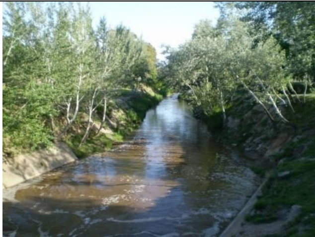
Image N°4: Cauce Arroyo Napostá en su recorrido por el Parque de Mayo
