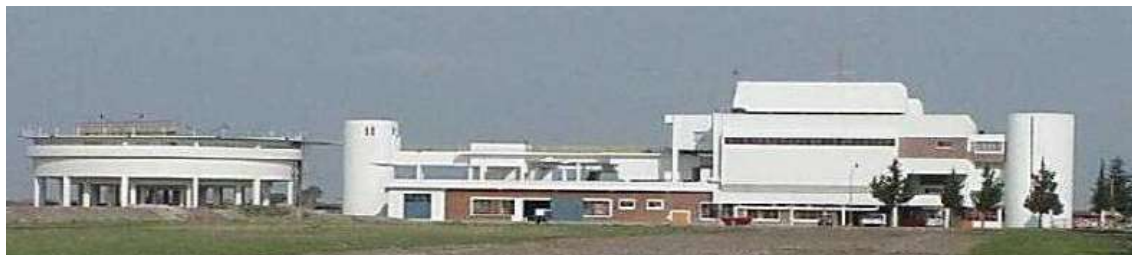
Figura 49. Planta potabilizadora Patagonia. Fuente: UTN FRBB Taller de problemática regional del agua.
