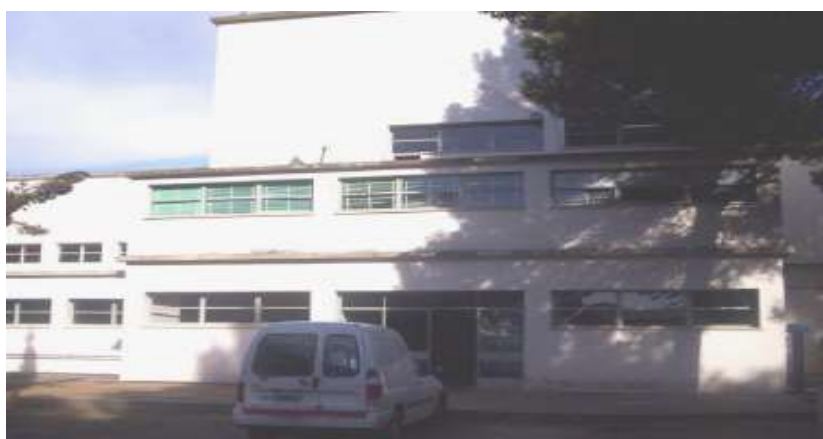
Figura 52. Planta potabilizadora Grünbein. Fuente: UTN FRBB Taller de problemática regional del agua.
