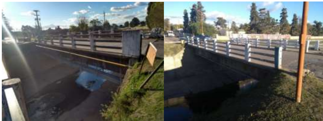
Figura 128. Puentes Vehiculares sobre canal. Fuente: Elaboración propia.
