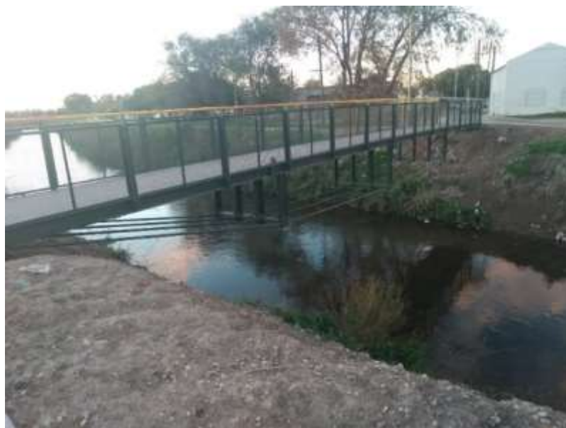
Figura 133. Puente peatonal calle Venezuela. Fuente: Elaboración propia.
