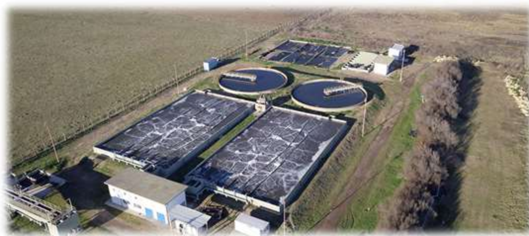
Figura 89. Planta de tratamiento de la tercera cuenca. Fuente: ABSA.
