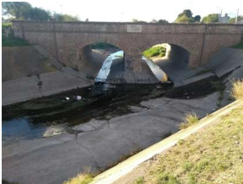
Figura 135. Puente ferroviario en calle Don Bosco. Fuente: Elaboración propia.
