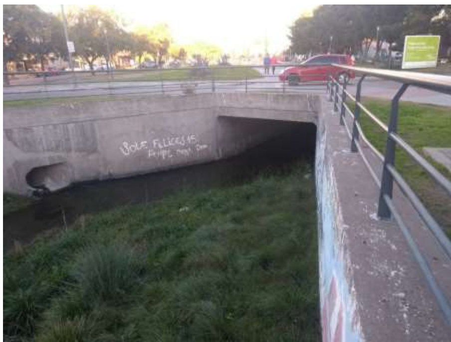
Figura 124. Boca del entubado. Fuente: Elaboración propia.
